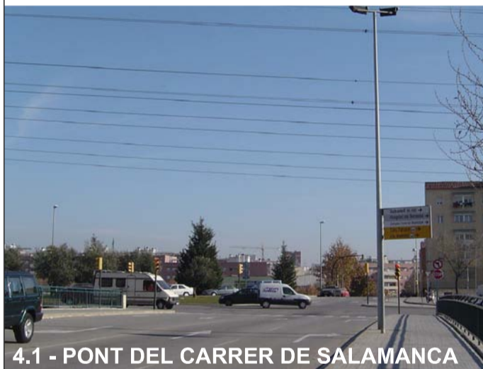
4.1 - PONT DEL CARRER DE SALAMANCA
