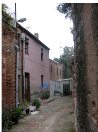
Imatge 10. Vista del carrer de Josep Rigol i Fornaguera abans de l'enderroc
