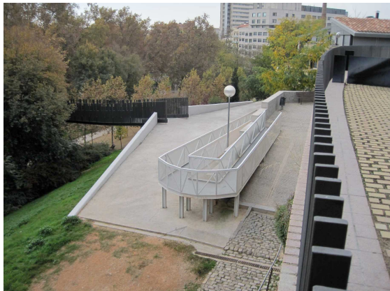
Imatge 22. Vista de l'actual rampa de connexió entre els dos nivells i el vestíbul de la passarel·la
