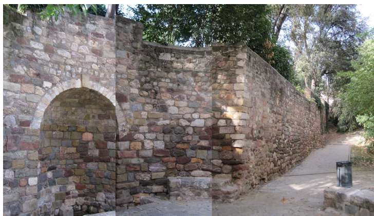
Imatge 19. Vista del mur de contenció i la Font de Santa Maria
