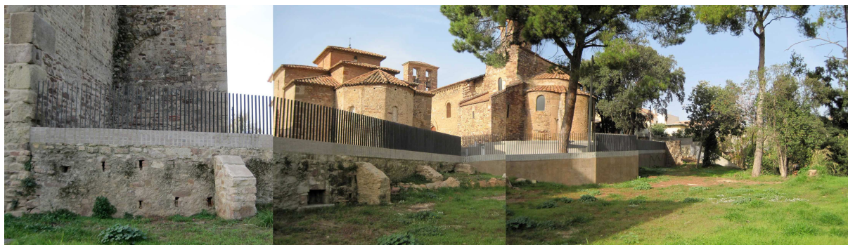
Imatge 20. Vista de la tanca del recinte de les esglésies de Sant Pere en direcció nord
