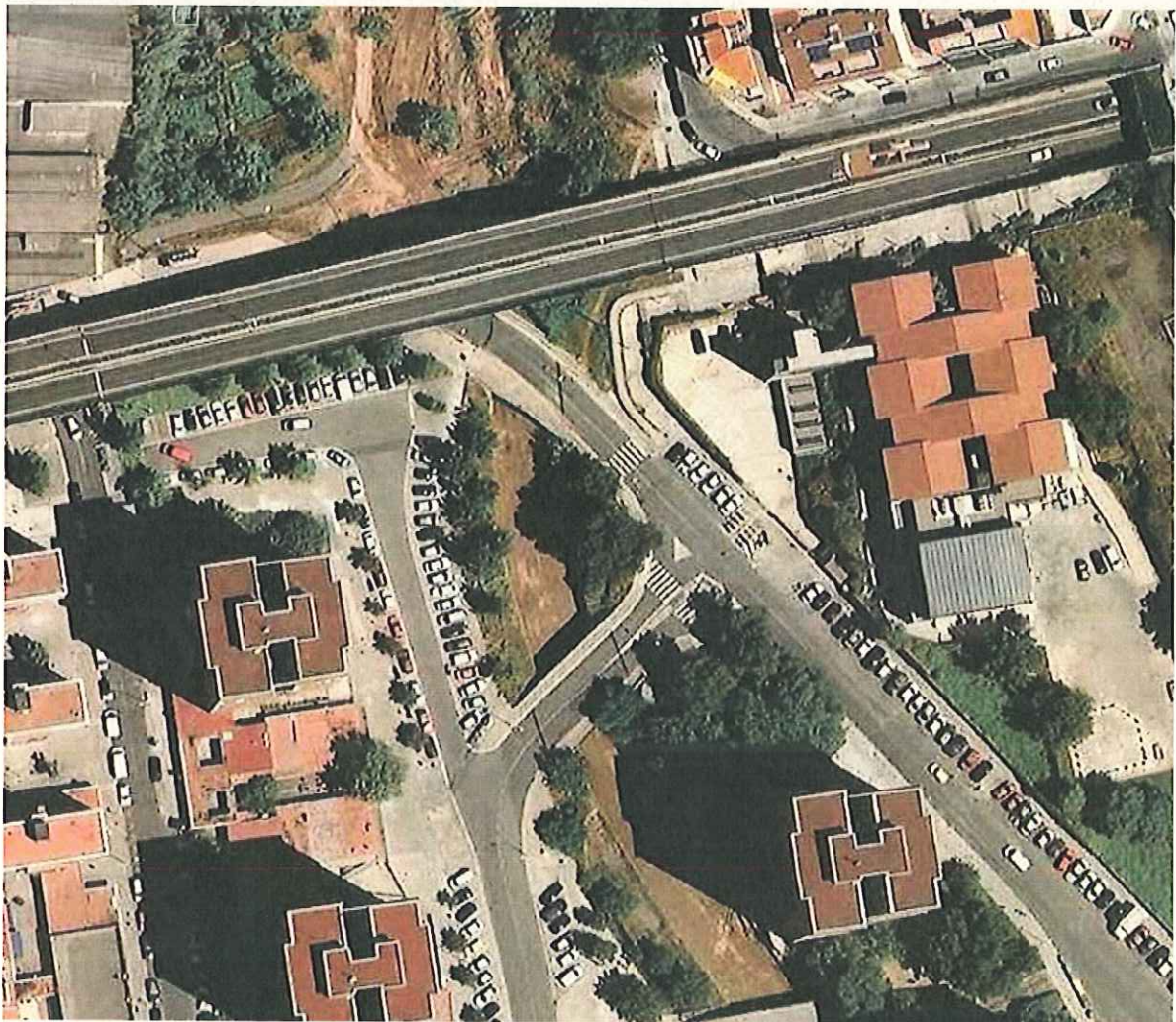
Detall del carrer de Vic abans de les obres, quan enllaçava amb el carrer Badalona passant per sobre el torrent.
