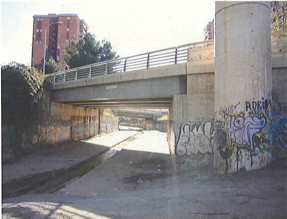
Encreuament del viaducte de l'Avinguda Santa Eulàlia i el carrer Badalona, abans del cobriment del torrent.
