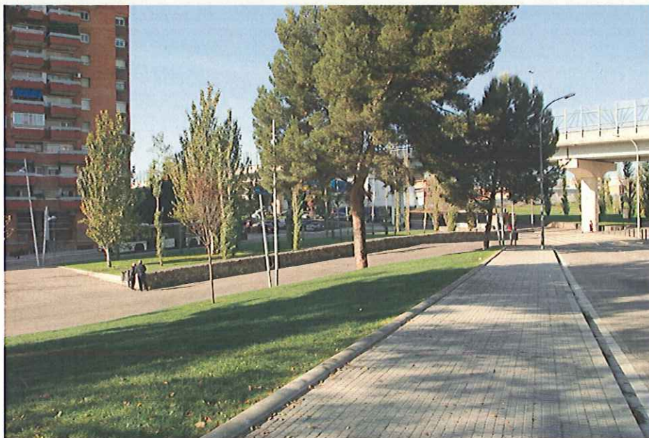
Imatge actual de l'enllaç dels dos carrers: en primer terme el carrer Badalona.
