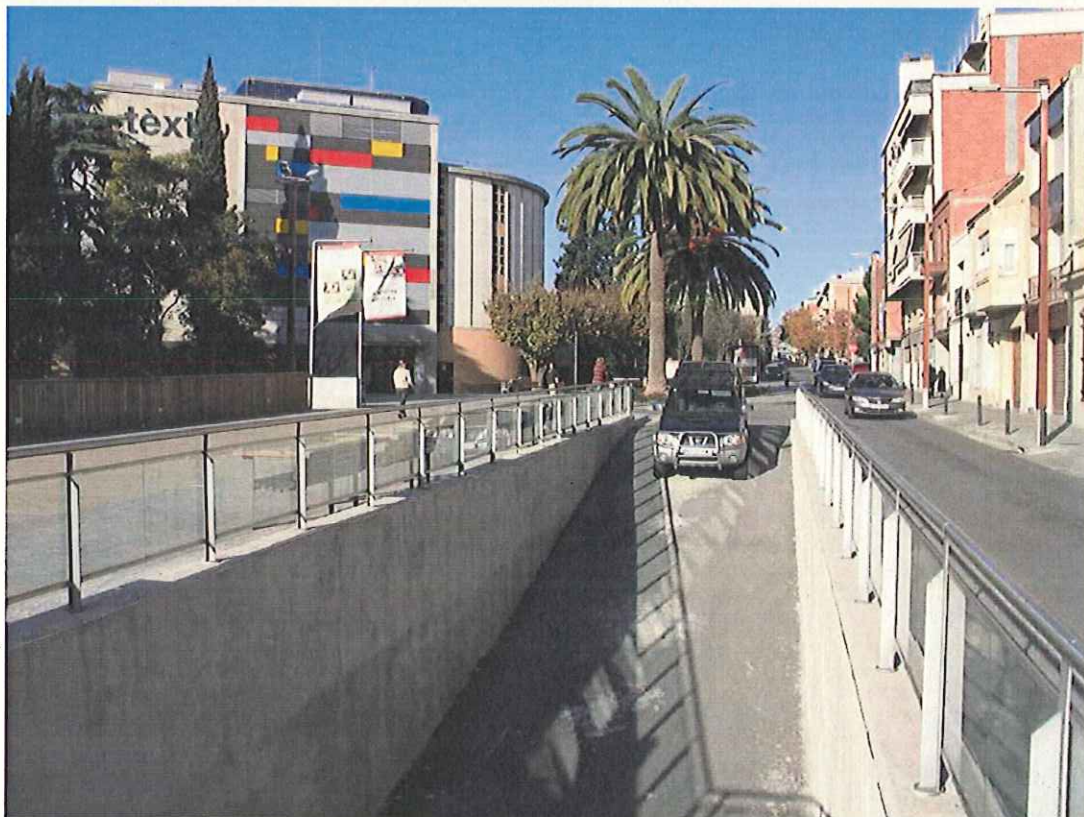
Rampa d'accés a l'estació, al carrer Salmerón
