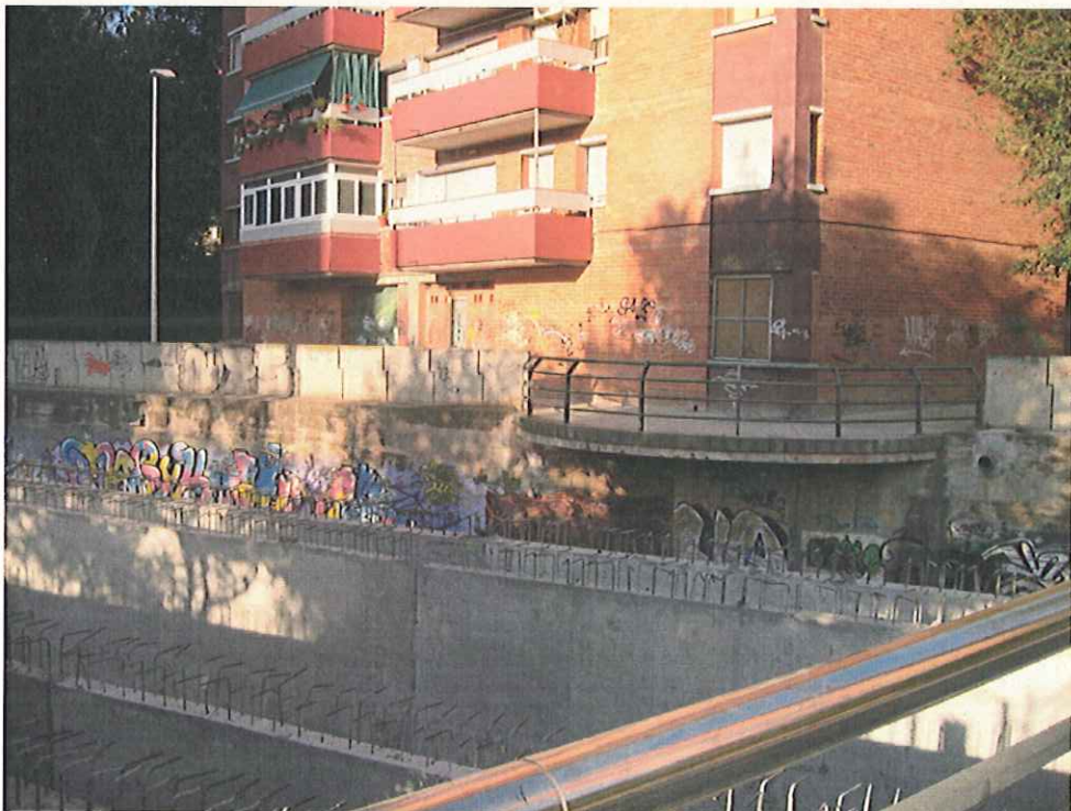
Construcció del col·lector
