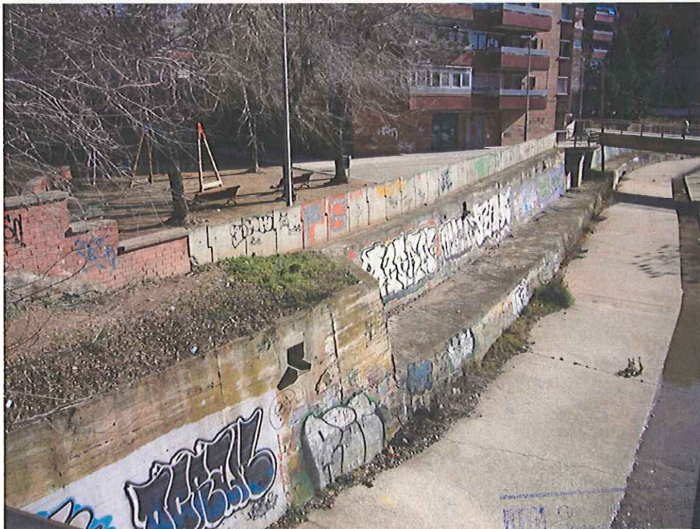
Aspecte que presentava l'àmbit abans de les obres de cobriment.
