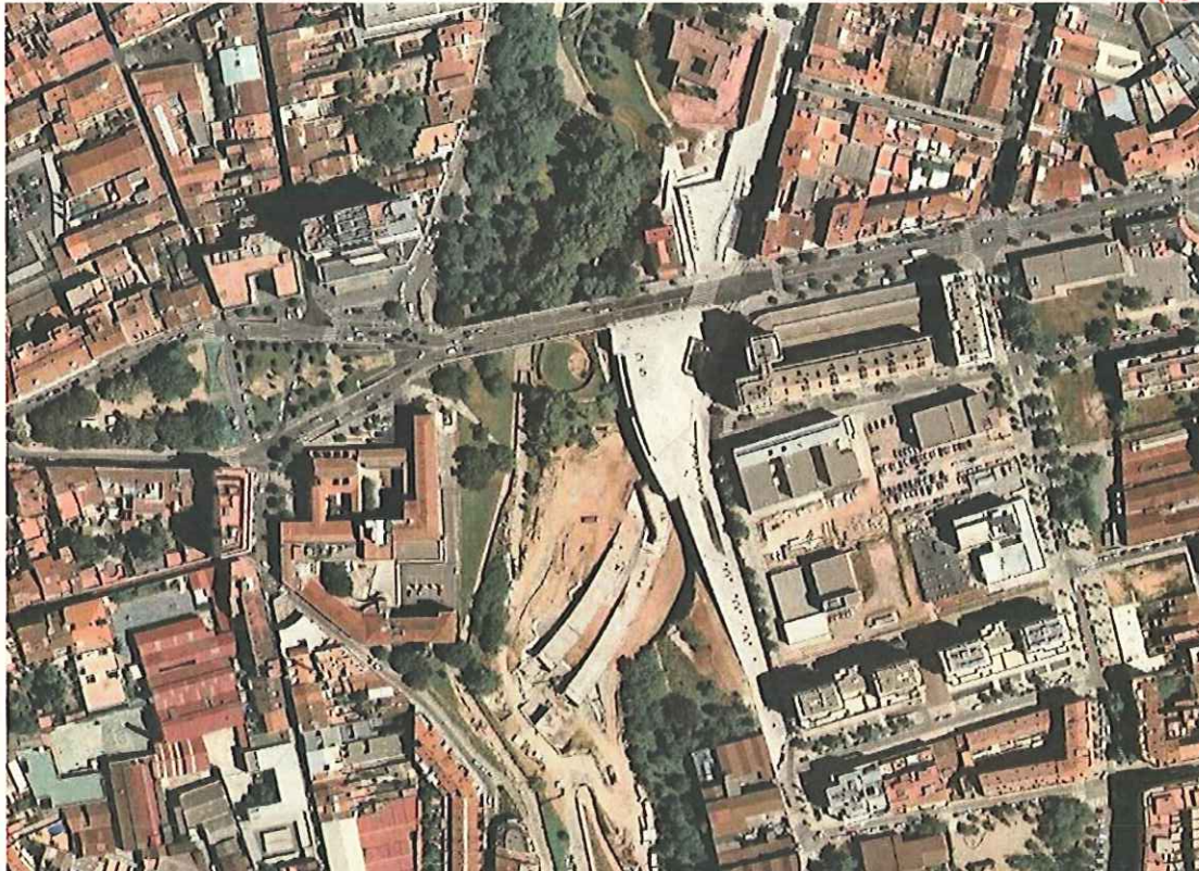
Imatge aèria de l'àmbit 3 durant la construcció de l'estació. S'observen els dos túnels de les vies.
