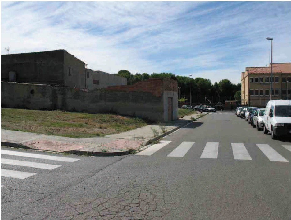
Cantonada Rioja amb Baracaldo, edificacions residencials existents
