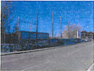
Foto 3. Imatge de la protecció de malla metàl·lica vist des de l'Avinguda del Vallès
