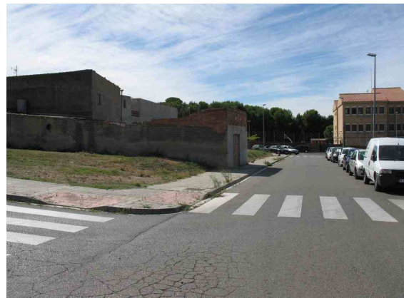
Cantonada Rioja amb Baracaldo, edificacions fora d'ordenació
