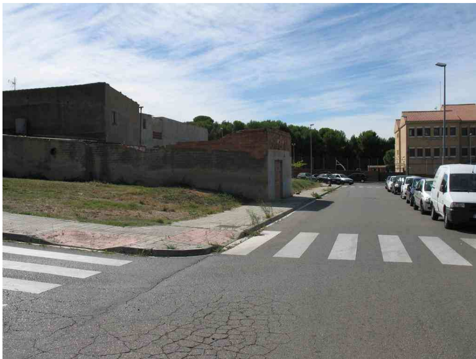
Cantonada Rioja amb Baracaldo, edificacions fora d'ordenació
