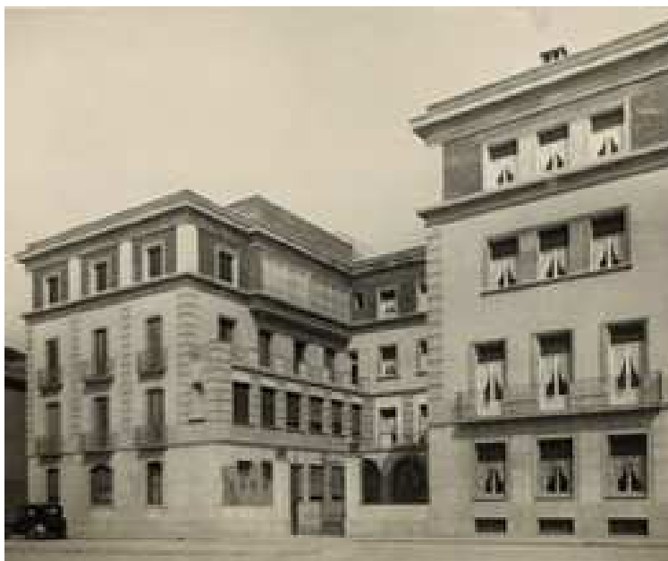
Façana clínica Quirúrgica, any 1947 (edifici A) (font: web Mútua Terrassa)
