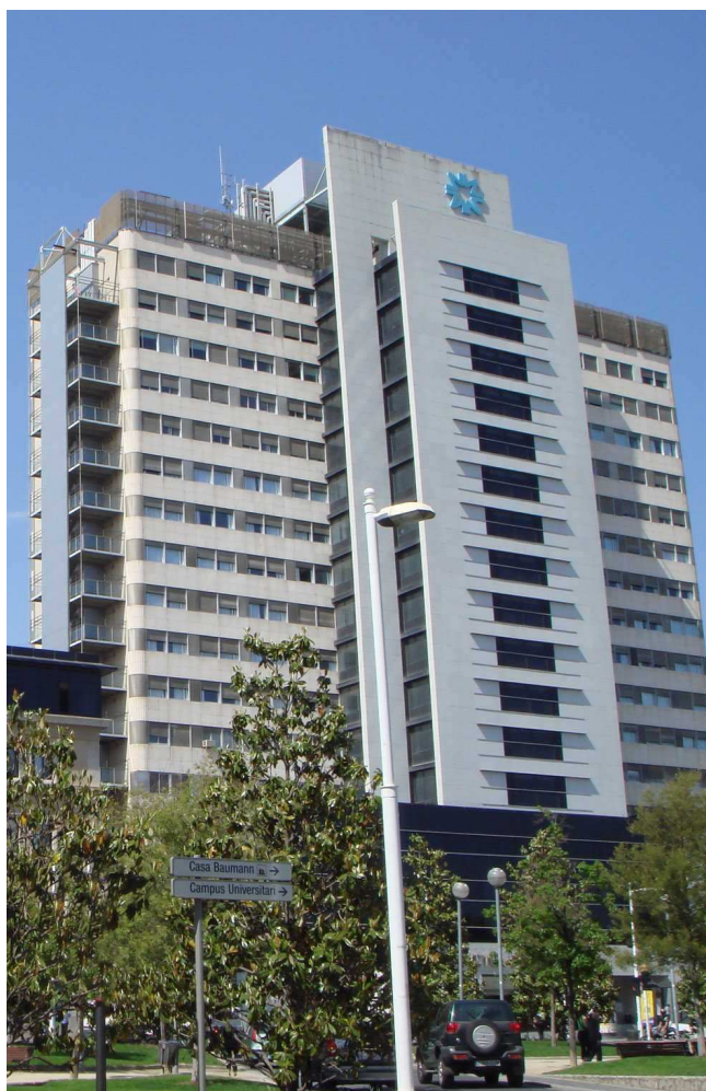
L'actual 'Hospital Universitari Mútua Terrassa, amb la darrera ampliació a la part central de la façana sud.
