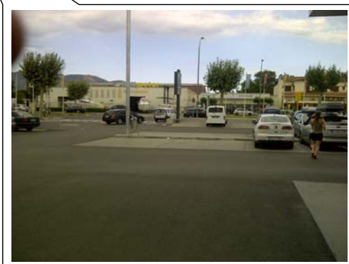
Superfície aparcament amb diferents materials per diferenciar zones estacionament
